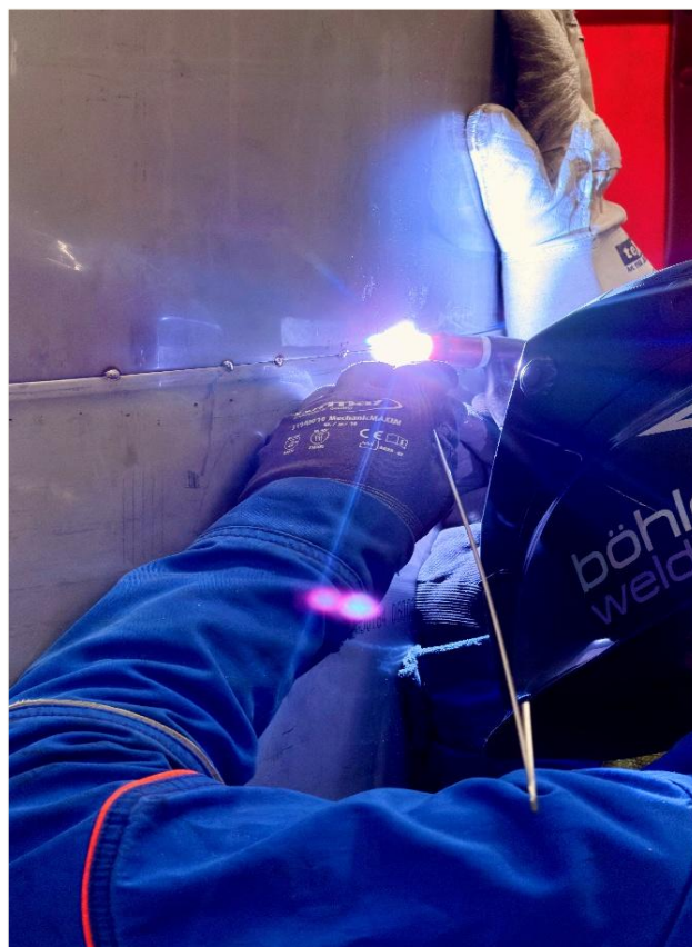
Vorrichten Behälter Ø 2500 mm S=5,0mm Werkstoff: 1.4571 für die Papierindustrie
