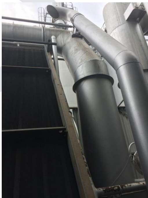
Rohrleitungen in DN 800 für die Wärmerückgewinnung
