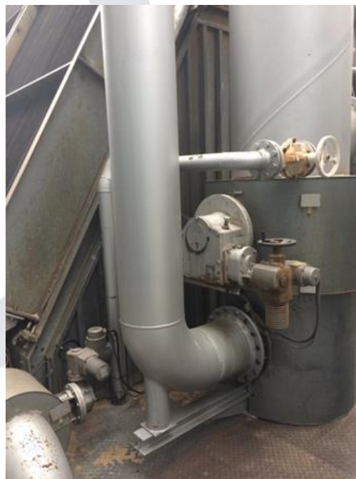
Rohrleitungen in DN 800 für die Wärmerückgewinnung
