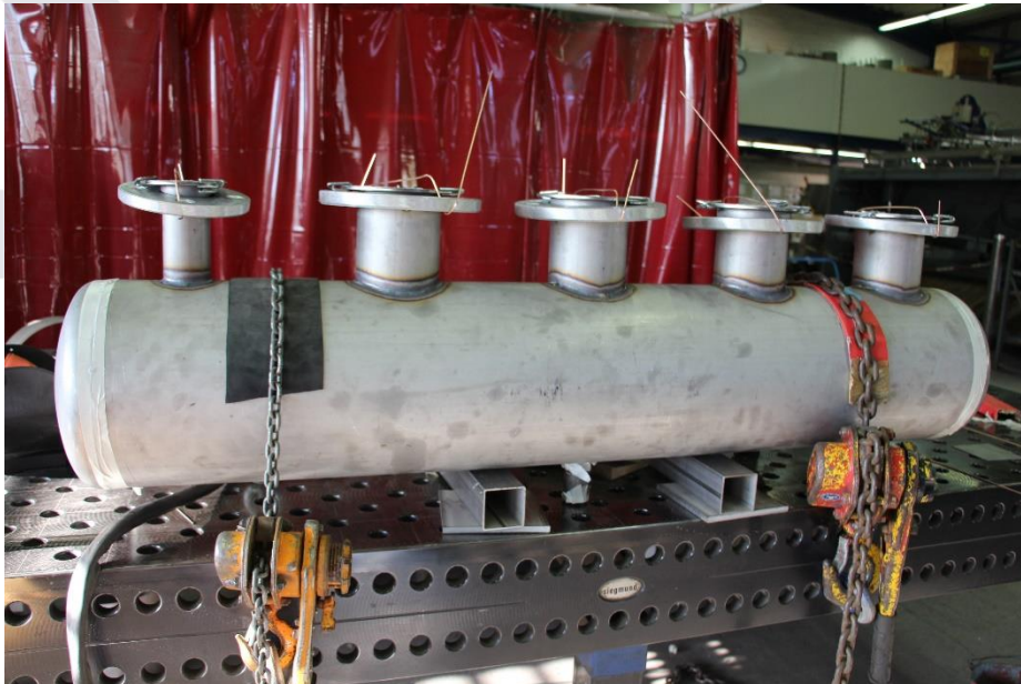
Vorfertigung Druckluftverteiler DN 250, Werkstoff-Nr. 1.4571
