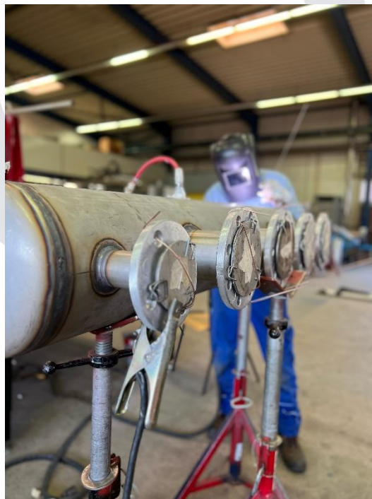
Schweißarbeiten am Druckluftverteiler DN250, Werkstoff-Nr. 1.4571
