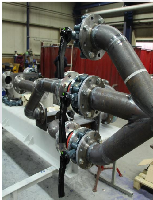
Vormontage Rohrleitung für eine Kühlwasserversorgung Werkstoff: P235GH TC1
