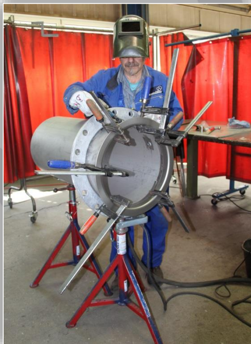
Vorfertigung Rohrleitung DN400 mit Vorschweißbördel und Losflansch PN10, Werkstoff 1.4571
