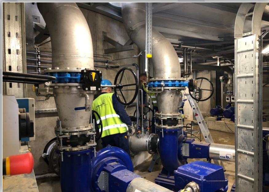
Montagearbeiten an einer Pumpengruppe
